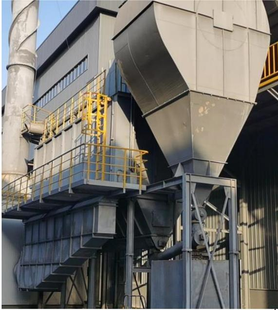
电炉及浇注废气除尘器
