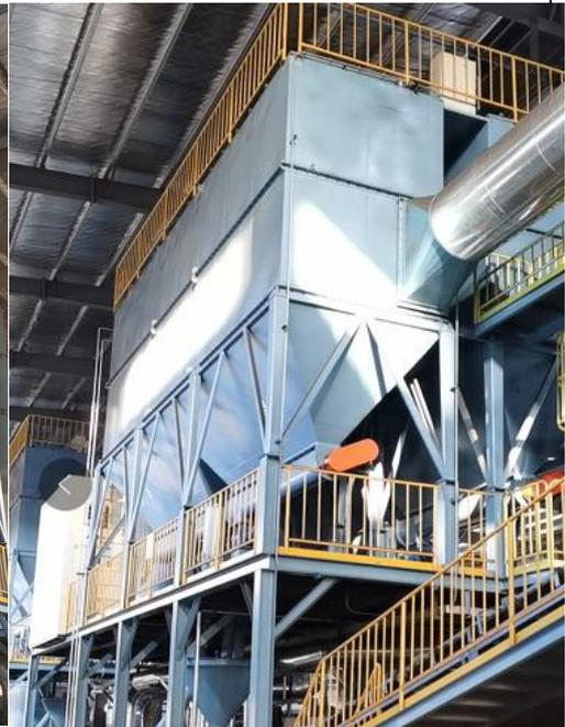
砂处理、混砂除尘器
